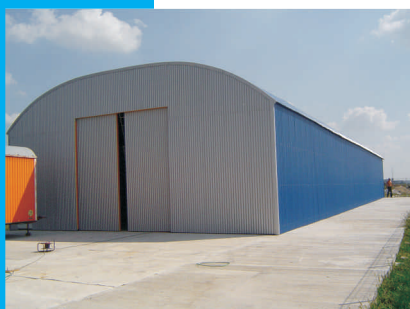
Hala de depozitare
