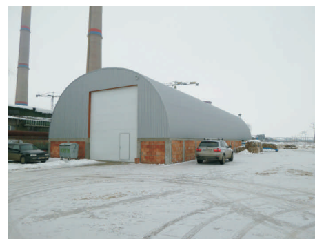
Rezolvarea unei extra opțiuni cu o poartă secțională supra dimensionată 5,0x6,0m
