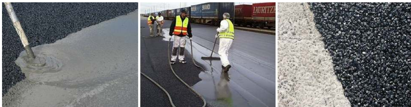
Faze de instalare ale sistemului CONFALT
