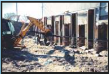
INCINTE LUCRĂRI SUBSOLURI, ȘANȚURI ȘI CANALE
