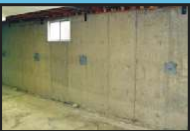
STABILIZAREA PEREȚILOR ȘI PLANȘEELEOR DE FUNDAȚII
