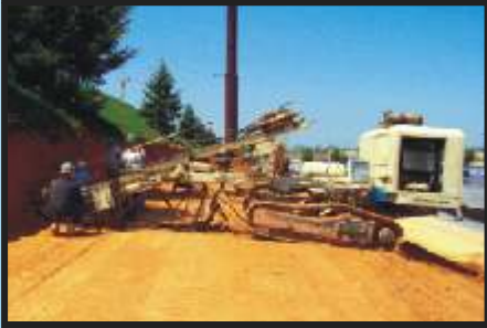
PICON (ATAȘAT PE BRAȚUL EXCAVATORULUI)
