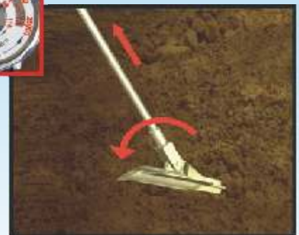
Bascularea ancorei în sol.
