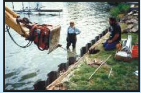
PLACĂ VIBRATOARE MONTATĂ PE BRAȚUL EXCAVATORULUI
