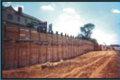
SUSȚINERE PEREȚI FUNDAȚIE
