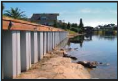
PROTECȚIE DE MALURI
