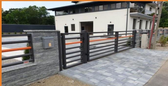
Poartă batantă cu înveliș din tablă
